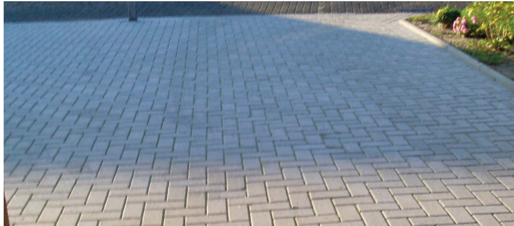
2 - Rijbaan parkeercoffers in grijze betonklinkers
